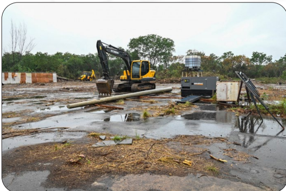
Visita ao espaço de obras do novo atacadista que será instalado na capital.
